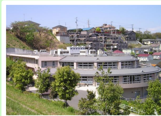
〔横浜市戸塚区〕 ヒューマンライフケア横浜 (介護老人保健施設)
